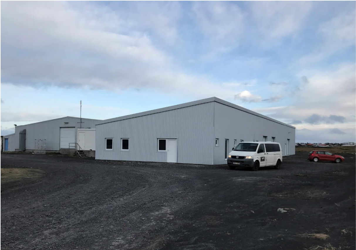
Mynd 3.3 Sláturhús Stofnfisks sem verið er að byggja.
