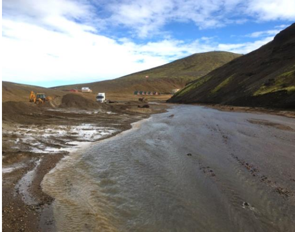
Mynd 22. Lón Sælufossvirkiunar september 2016.
