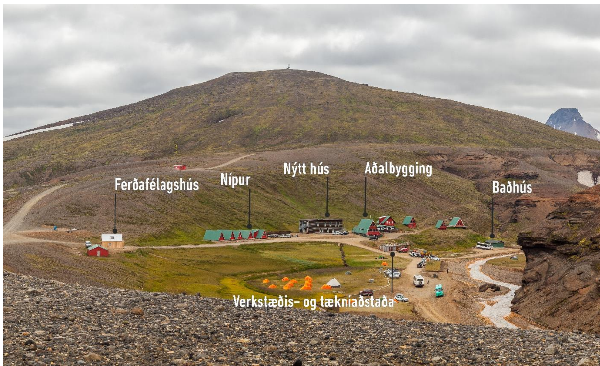
Mynd 3. Mannvirki í Ásgarði sumarið 2016.
