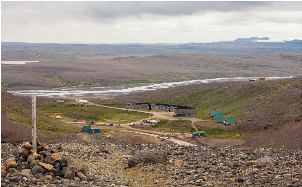
Mynd 14. Valkostur 3. Lokið hefur verið við 2. og 3. áfanga nýbyggingar hálendismiðstöðvar.
