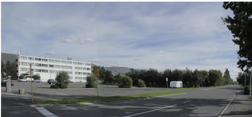
Mynd 22. Núverandi ástand við tjaldstæðið við Þingvallastræti.
