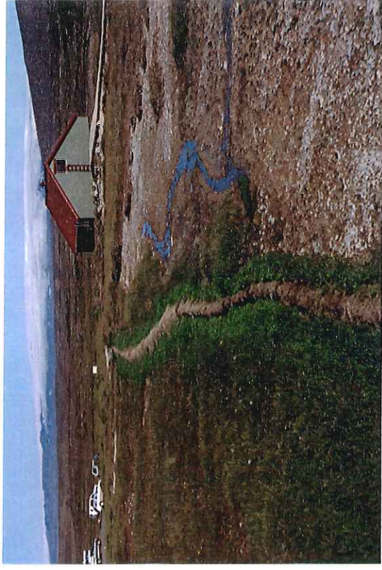
19. ljósmynd. Hítalögn við eldri skála Ferðafélagsins. Rör hefur verið lagt á yfirborð og kleitt með þökum.
