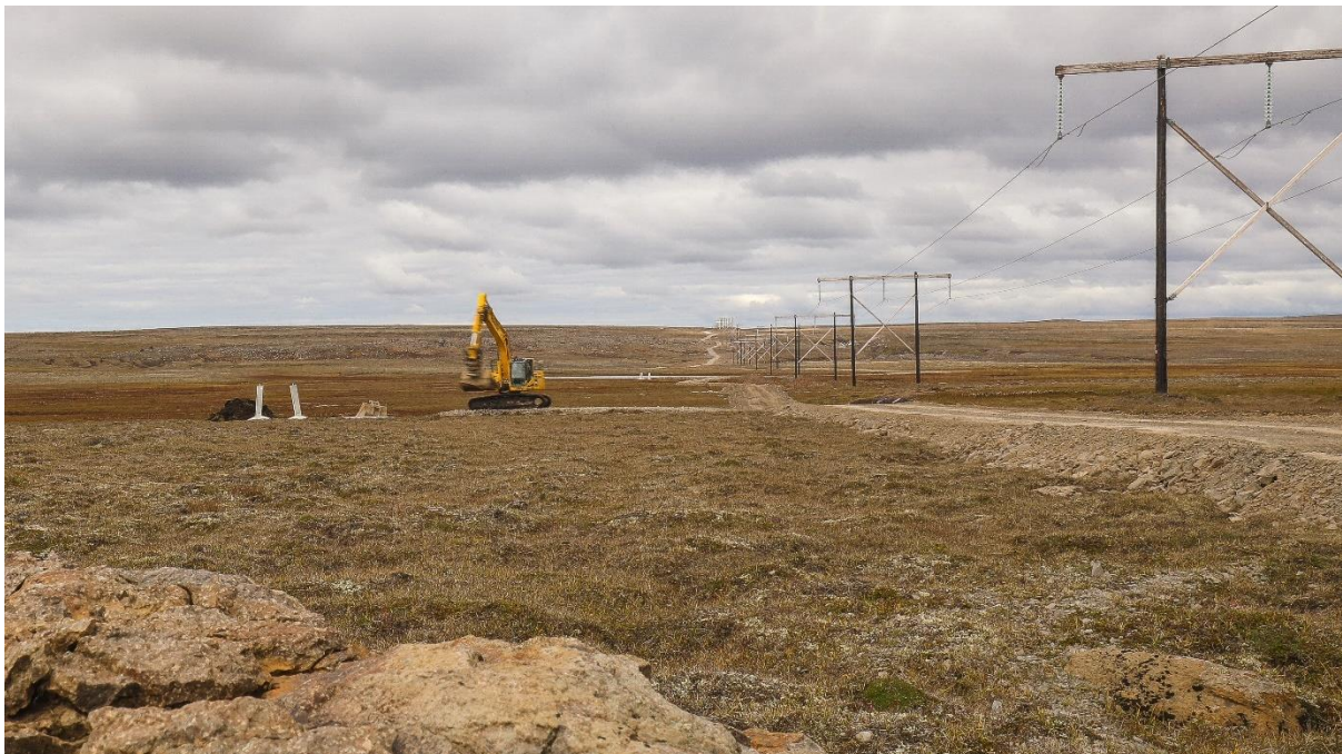
Mynd 6.7. Slóðagerð við Kröflulínu 3. Á myndinni sést núverandi 132 kV loftlína þar sem lögð hefur verið slóð samsíða og undirbúin mastraplön fyrir nýja 220 kV Kröflulínu 3.
