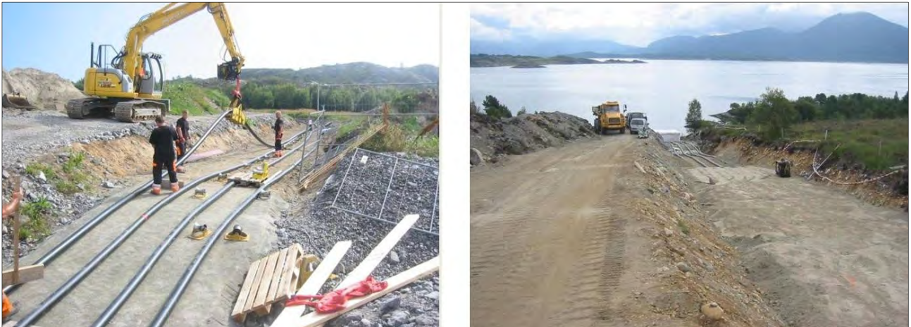
Mynd 3.7 Dæmi um umfang á lagningu háspenntra jarðstrengja erlendis (220-400 kV).
