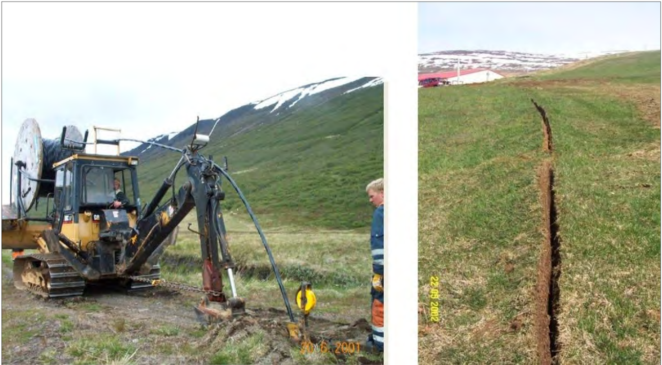
Mynd 3.5 Dæmi um skurð við plægingu á 11 kV streng í dreifikerfinu við Ljósavatn.
