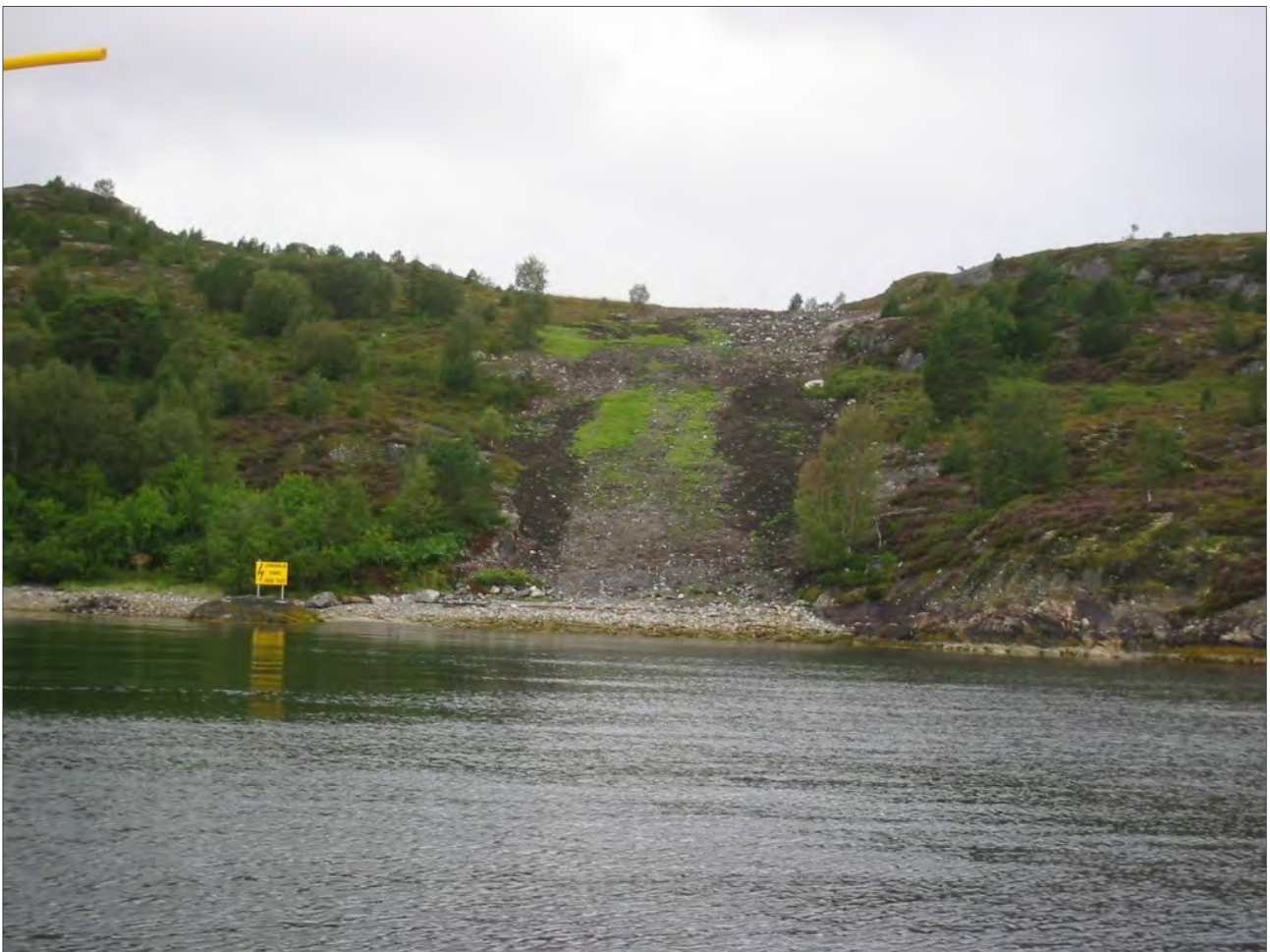
Mynd 3.8 Erlent dæmi um frágang eftir jarðstreng.
