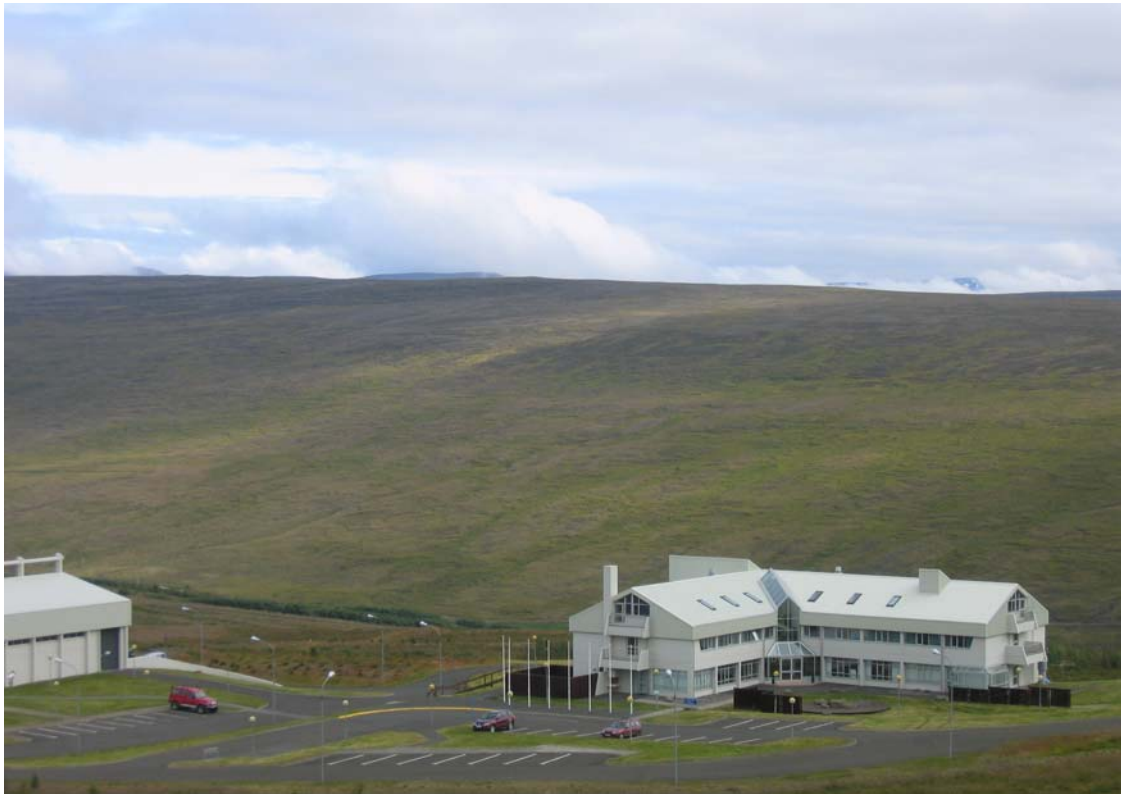
Mynd 8 Blönduvirkjun. Myndin er tekin frá útsýnis og upplýsingaútskoti á Kjalvegi. Blanda rennur um gilið fyrir aftan Blönduvirkjun. Handan gilsins er austurhlíð Blöndudals. Línunni er ætlað að fara yfir gilið, skáhallt upp hlíðina, uppá hálsinn og fylgja honum endilöngum í u.þ.b. 1 km leið. Ljós. G.Ólafsdóttir.
