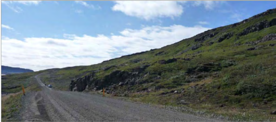
Mynd 6.10.19. Horft úr stöð 3400-3450 út vestanverðan Mjóafjörð. Á þessu svæði eru áætlaðar miklar skeringar sem munu ná 40 m upp í hlíðina frá núverandi vegi auk þess sem vegurinn verður færður nær fjörunni og 7 m niður í núverandi landslag. Skeringin sést á mynd 6.10.20.
