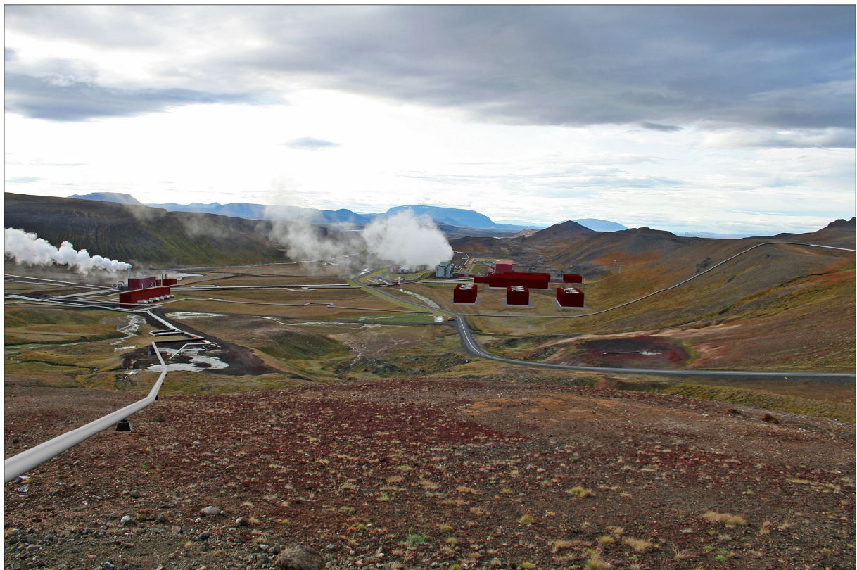
Mynd 9.38 Ásjón frá útsýnispalli, norðan Kröflustöðvar með tilkomu Kröfluvirkjunar II (myndatökustaður 5 á mynd 5.1). Kæliturnar nýju virkjunarinnar eru sýndir án gufu til að skyggja ekki á önnur virkjunarmannvirki.
