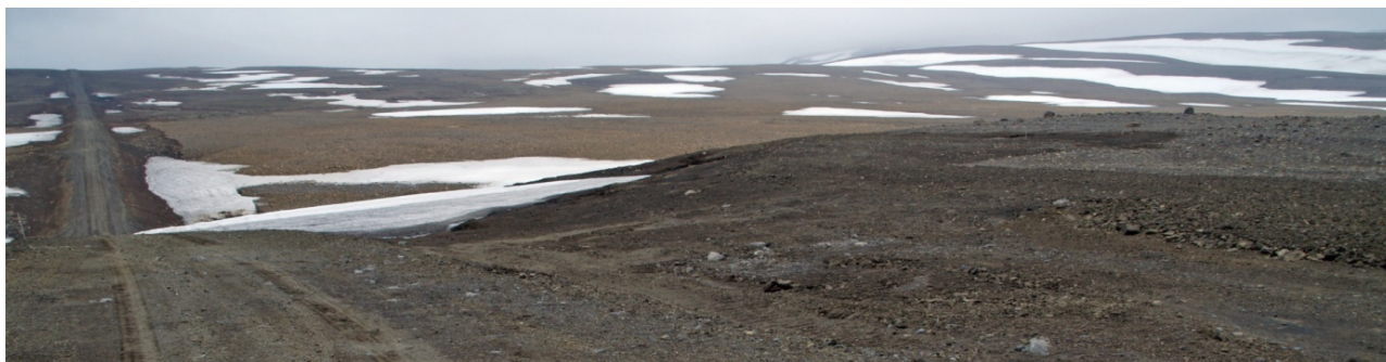
Mynd 5. Náma RHN-2 er í vegskeringu á Reykjaheiði. Þarna þarf að taka veginn talsvert niður og við það fæst efni sem rétt er að nýta til vegagerðarinnar eftir föngum.
