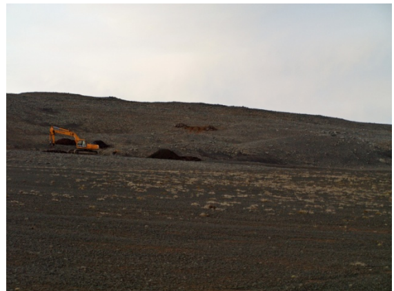
Mynd A- 29. Horft til gryfju RG-28 frá RG-29. Gryfja RG-27 er aftan við gröfuna.
