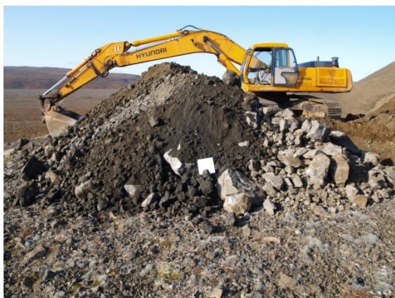
Mynd A- 33. Efnið úr gryfju RG-32 er ágætt í fyllingar fyrir vegagerð. Í því er talsvert af grjóti sem hægt er að brjóta til að fá betri kornadreifingu.
