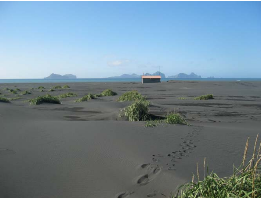
Mynd 16.1 Vatnsdælustöð neysluvatns til Vestmannaeyja umlukin síbreytilegum sandi. Vestmannaeyjar í baksýn. Mynd: Elín Fjóra Þórarinsdóttir 2007.
