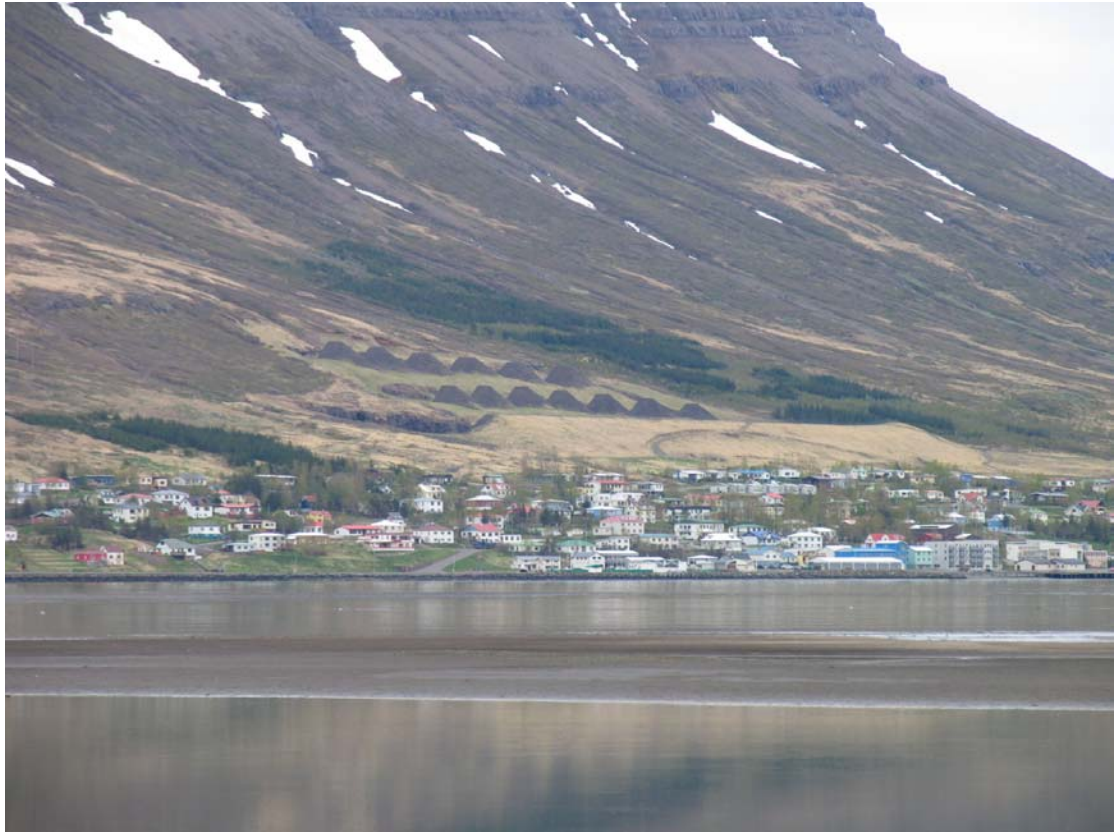
Mynd 18. Snjóflóðavarnargarður í Neskaupsstað.
