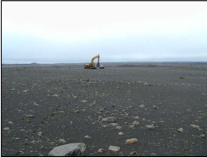
Mynd 4.28. Náma B-4. Horft til norðurs (Vegagerðin, júní 2005).
