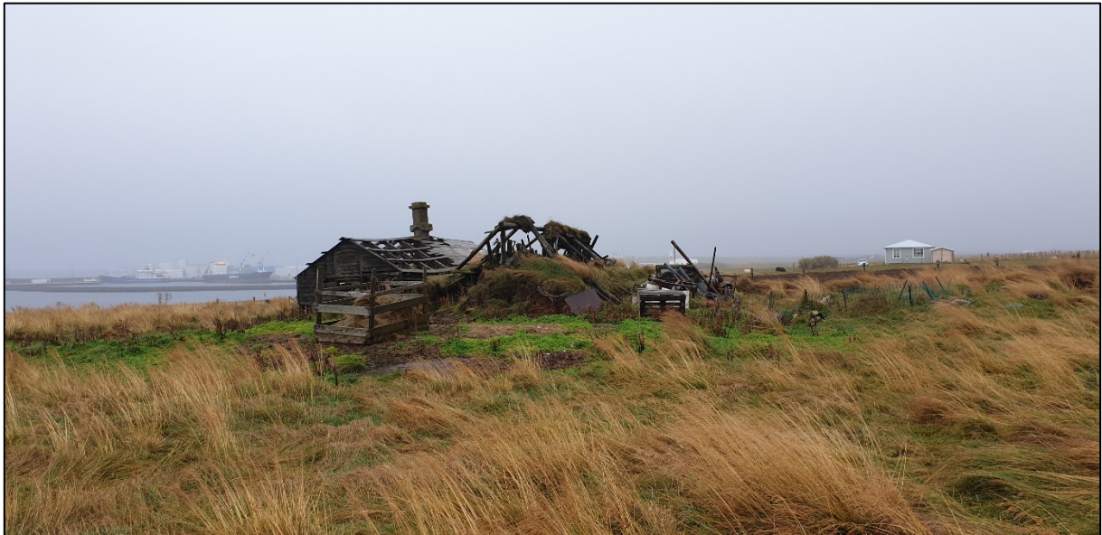
Vegamót 065_1 og 2, horft til NNV
