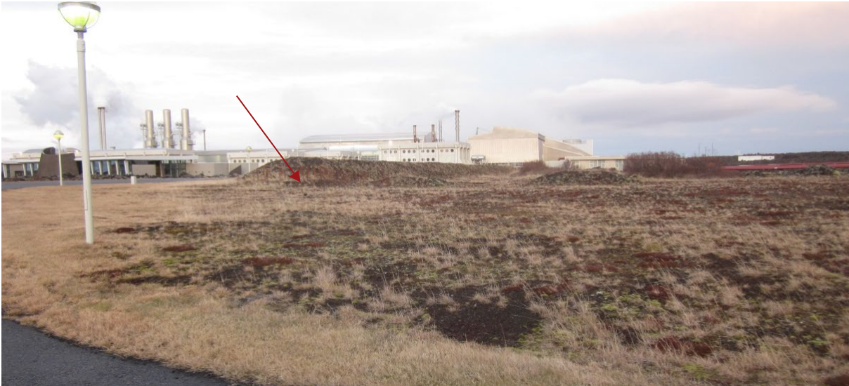
Mynd 6.5 Frágengin lokuð borhola nr. 5 í Svartsengi. Rauð ör bendir á holustút sem stendur upp úr yfirborðinu. Við frágang var sáð í svæðið og landið mótað
