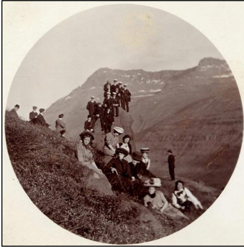
Mynd 3. Gömul mynd sem sýnir samkomu á áfangastað NM-249:037 við Neðri-Gufufossbrekku. Höfundur óþekktur.
