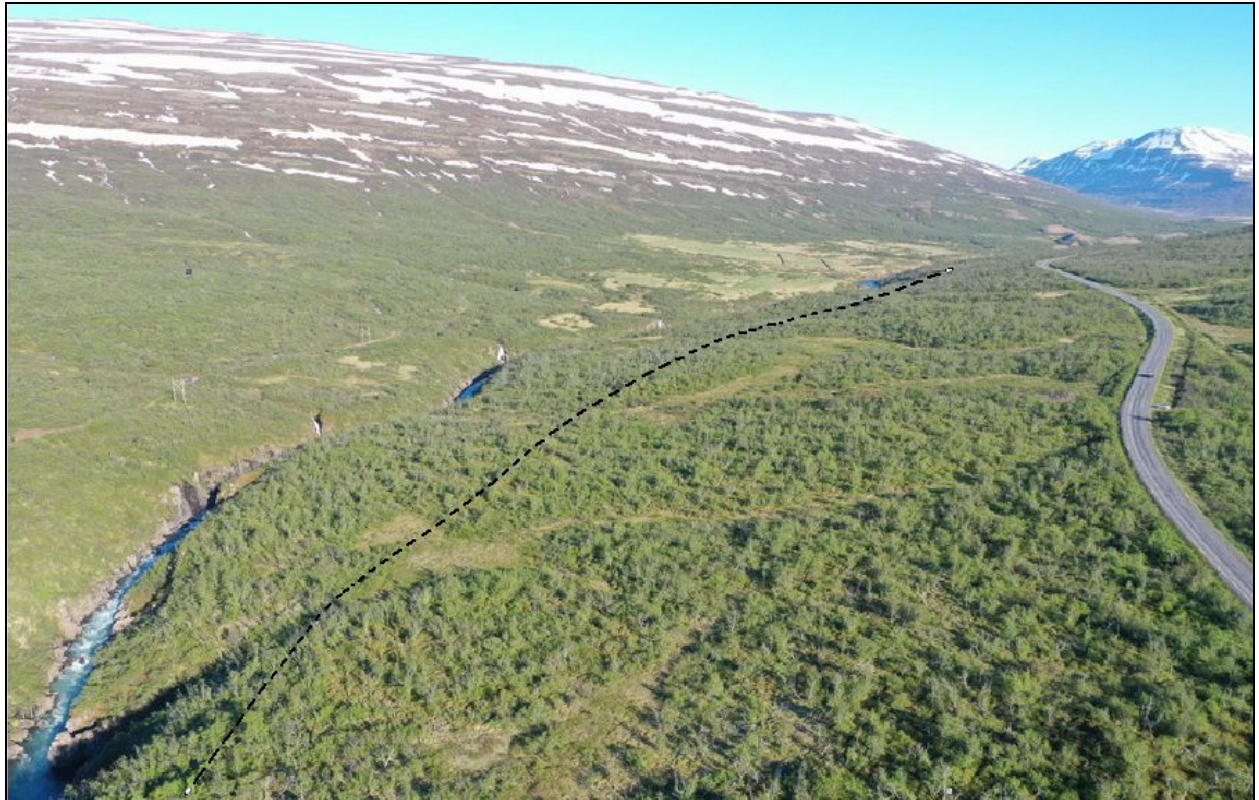
Mynd 2.3.4. Miðleið nærri stöð 1200 þar sem veglínan liggur tæplega 100 m frá gilbrún Eyvindarár.
