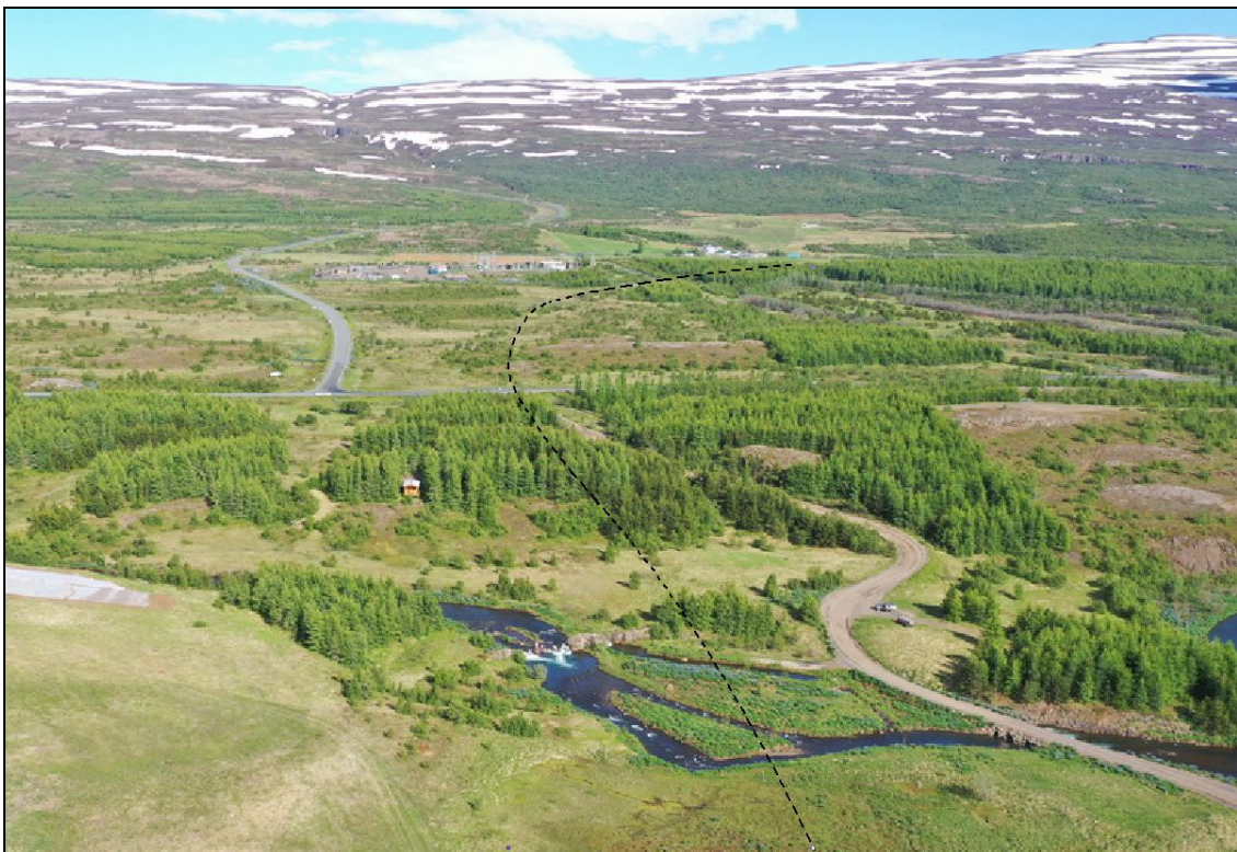
Mynd 2.2.5. Horft suður yfir vegstæði Norðurleiðar (nærri stöð 2400) frá Uppsalaá (skammt frá Myllufossi) upp til Fjarðarheiðar. Veglínan liggur til hægri við spennistöð RARIK og Steinholt í fjarska.
