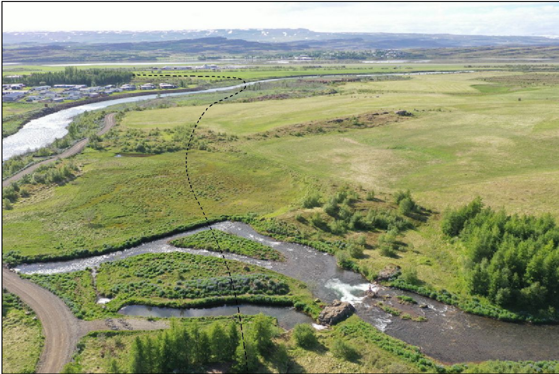
Mynd 2.2.4. Horft norður yfir vegstæði Norðurleiðar við Uppsalaá (nærri stöð 2500). Flúðin á myndinni þar sem áin rennur yfir berggang nefnist Myllufoss. Veglínan liggur nærri honum væri æskilegt að sveigja hana fjær flúðinni. Brú yrði byggð á Eyvindará (í fjarska) þar sem veglínan sveigir fyrir norðurenda byggðarinnar.
