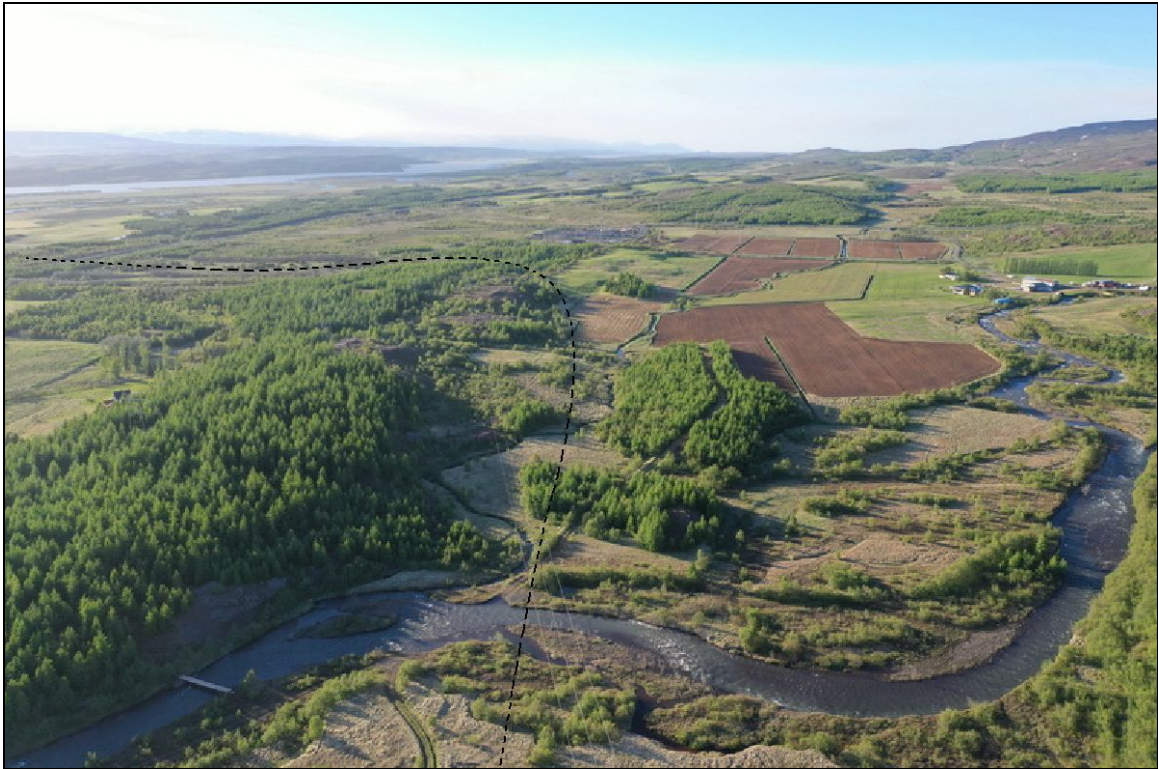
Mynd 2.2.6. Horft norður yfir Norðurleið (nærri stöð 4000) frá Miðhúsaá. Brúarstæði á Miðhúsaá er nærri miðri mynd og veglínan liggur þaðan eftir skógræktarsvæði og meðfram norð-vestur jaðri túna frá Steinholti.
