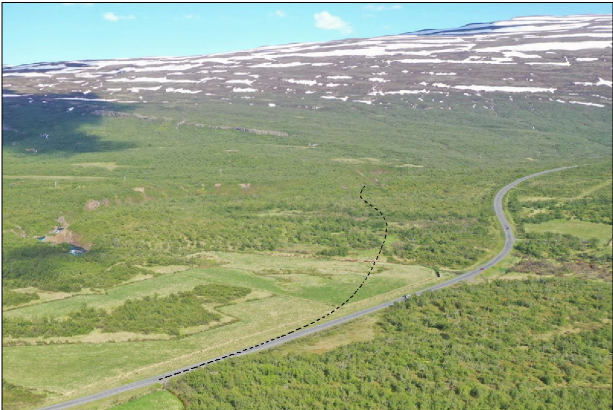
Mynd 2.3.1. Byrjunarstöð Miðleiðar (0-stöð) er neðst á myndinni og víkur til vinstri út frá Fagradalsbraut neðan við Selbrekku (nærri bíl sem sést á brautinni). Fjær liggur leiðin austur að gili Eyvindarár.
