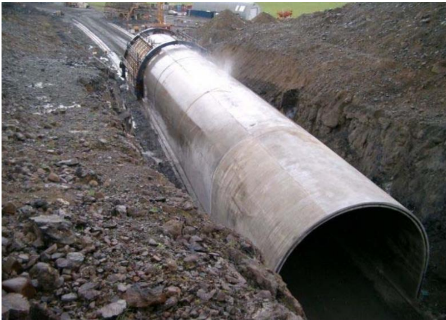
Mynd 8.1 Bygging vegskála í Fáskrúðsfirði (Ljósmynd: Sigurður Oddsson, ágúst 2004).
