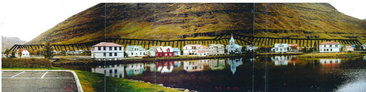
Mynd 19.13 Fyrri hugmyndir um varnargarða á Seyðisfirði eins og þeir voru skissaðir upp árið 1999 (Hönnun og Ráðgjöf Verkfræðistofa, 1999).
