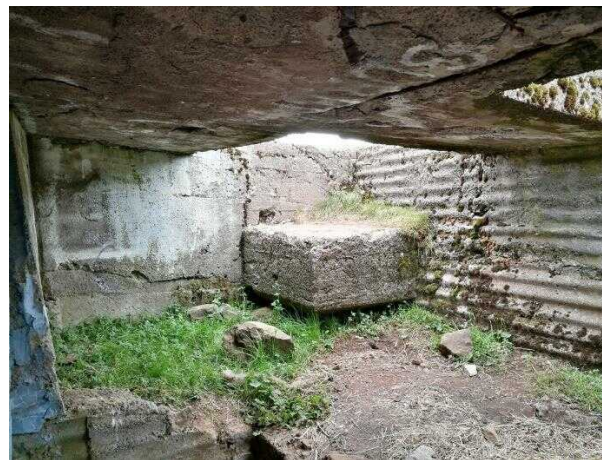
Mynd 23. Myndin er tekin ofan í byggingunni.
