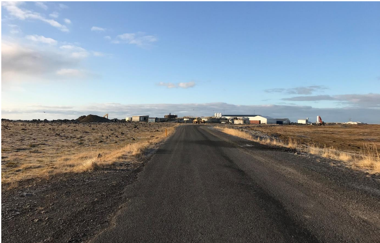
MYND 5-18 Horft til suðvesturs yfir eldisstöð Íspórs frá Nesbraut.
