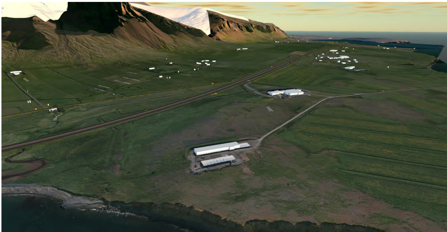
MYND 13b Horft til suðausturs eftir Vesturlandsvegi. Sjónarhorn staðsett um 180 m yfir landi við Saltvík 3. Eftir framkvæmdir. Mynd: Verkís.
