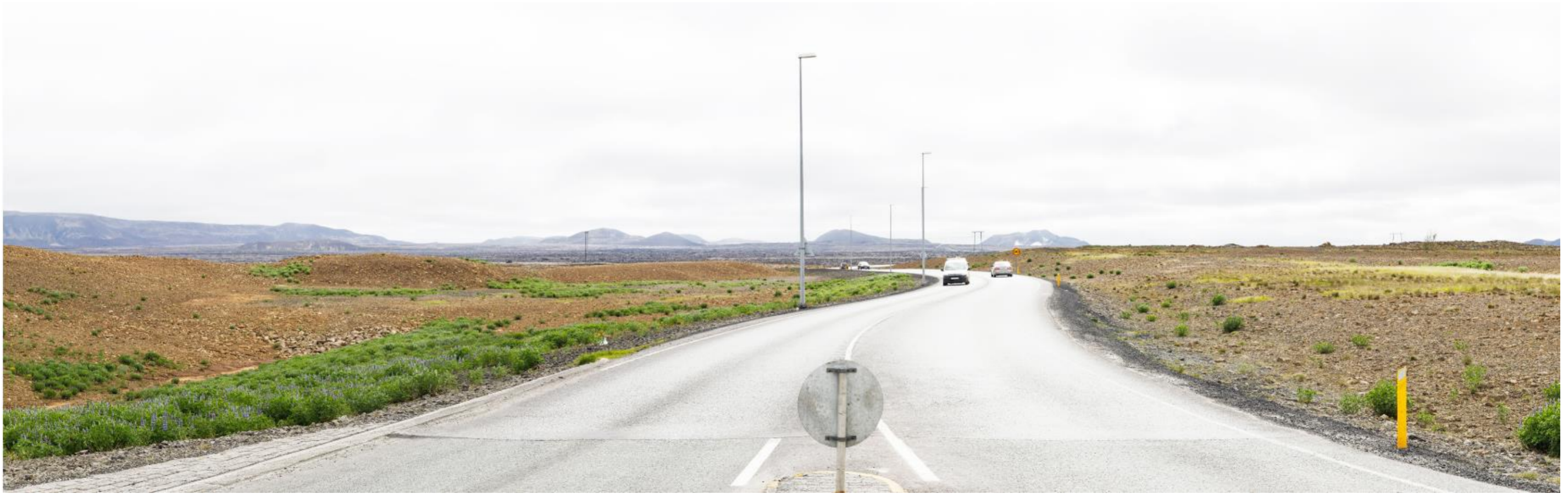
Mynd 24 | Myndapunktur 8. Við gatnamót Reykjanesbrautar og Grindavíkurvegjar. Núverandi ástand.
