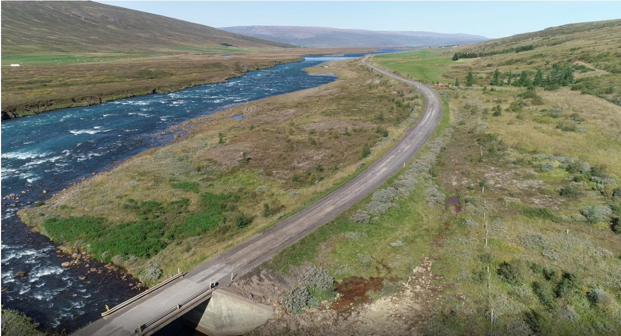
Mynd 4.13 Horft til norðurs brú við Kálfborgará yfir það svæði þar sem gert er ráð fyrir að frárennslisskurður muni liggja og mæta Skjálfandaflljóti. Svæðinu neðan vegar hefur verið raskað vegna vergagerðar fyrr á árum.
