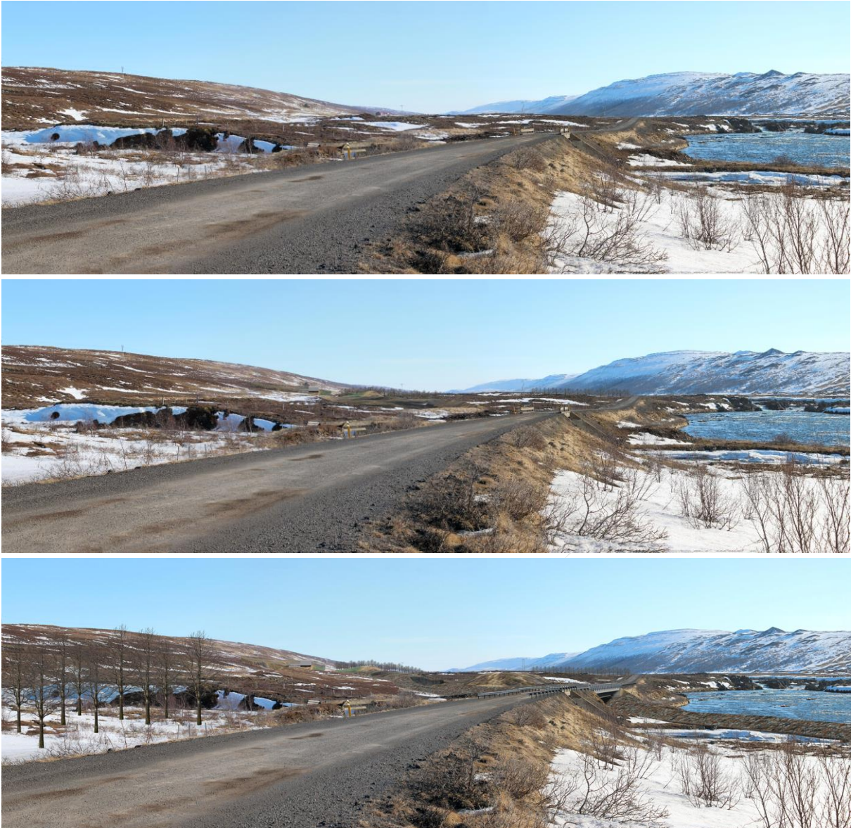
Mynd 7.45 Staður E. Horft til suðurs við brúnna yfir Kálfborgará. Miðjumyndin sýnir tilhögun A með göngum undir ána en skurður tæki við norðan við þann stað sem myndin er tekin. Neðsta myndin sýnir tilhögun B með frárennsli í skurði alla leið frá stöðvarhúsi.
