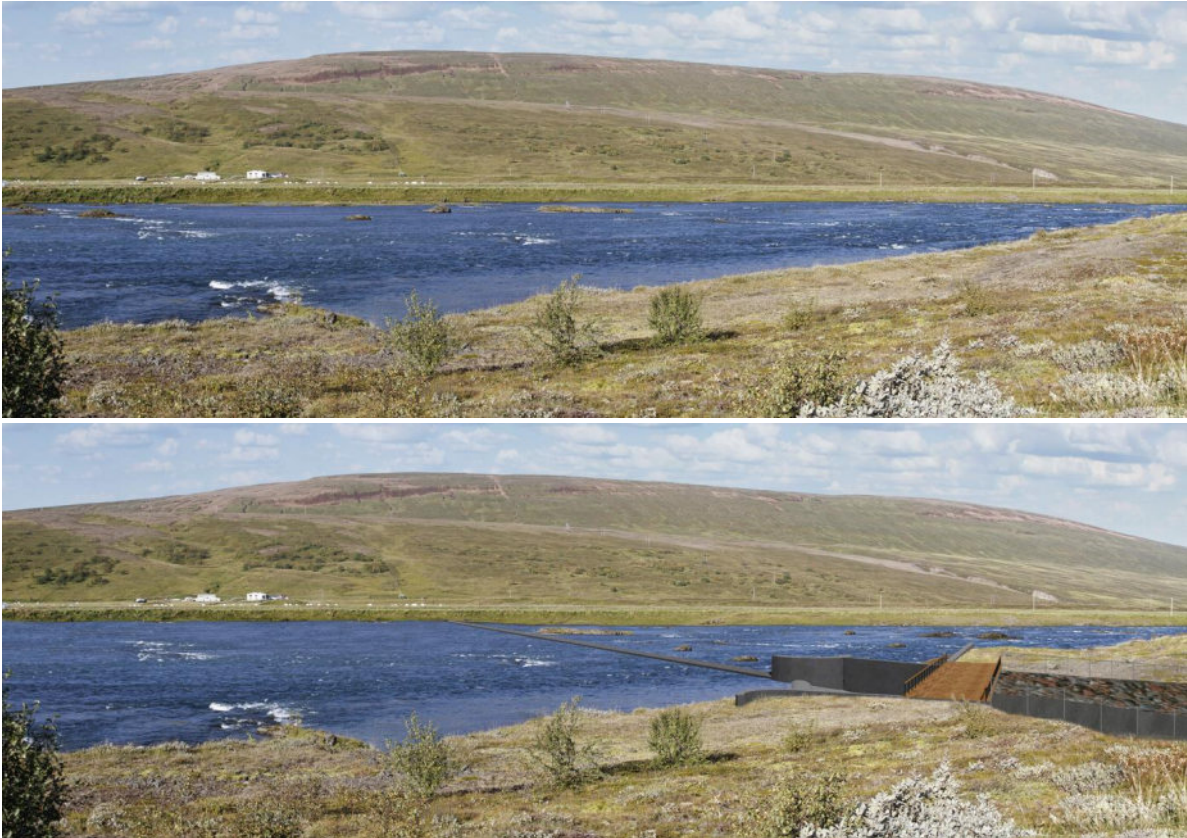
Mynd 7.41 Staður B. Horft er frá austurbakka Skjálfandafljóts að fyrirhuguðu yfirfalli og inntaksmannvirki. Yfirfallið mun að jafnaði ekki sjást frá miðjum apríl fram í miðjan desember.
