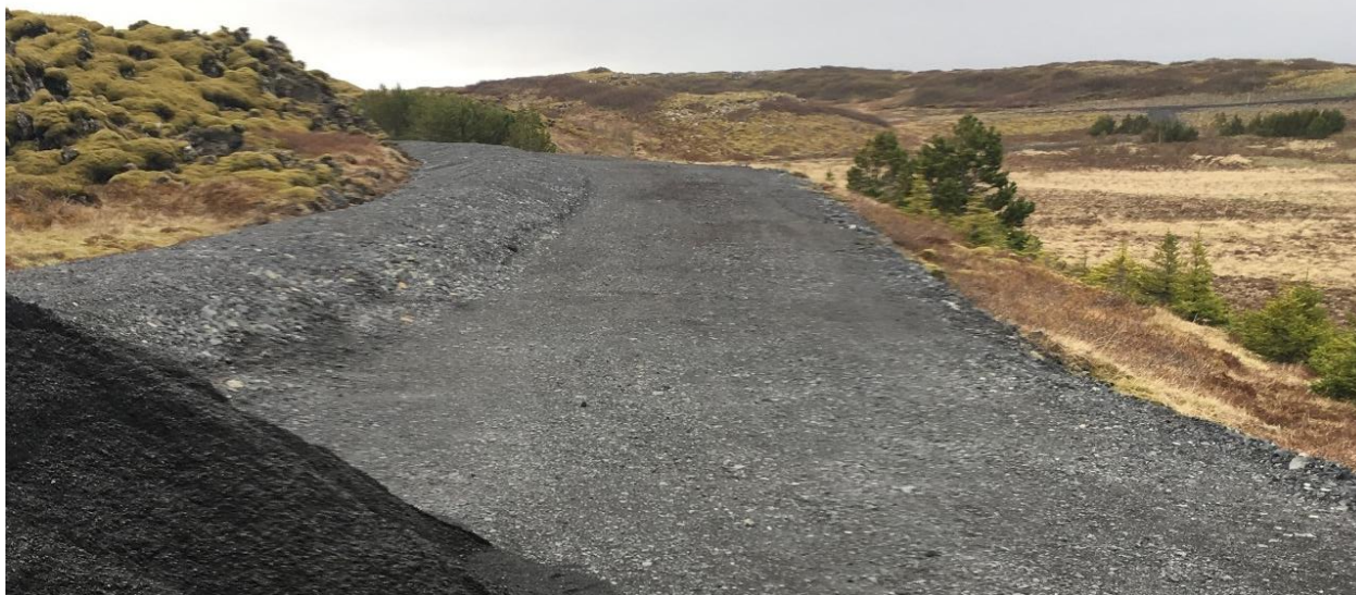
Mynd 3.2 Hluti framkvæmdasvæðis í Vatnsendakrikum, séð meðfram vegi að borholu VK-03.
