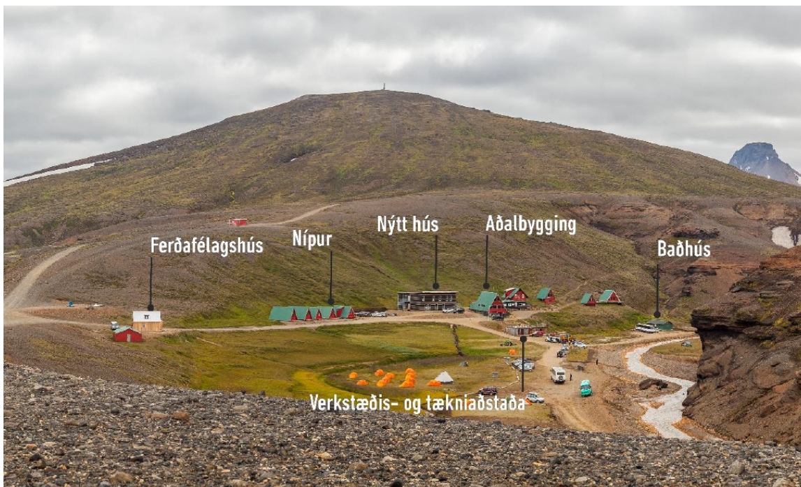
Mynd 2 Mannvirki í Ásgarði árið 2016. (Mynd 3 úr matsskýrslu Fannborgar.)
