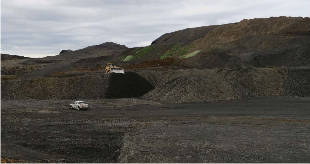
MYND 3.8 Jarðýta ryður fram efni af Stapafelli. Mynd tekin af EFLU verkfræðistofu í júlí 2018.
