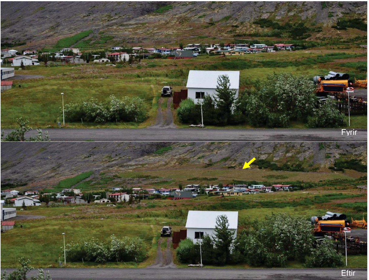
Mynd 10.31 Möguleg ásjón á Sigtúnssvæðið fyrir og eftir framkvæmdir. Tillögur að landmótun hafa verið færðar inn á myndina. Mynd: Verkis.
