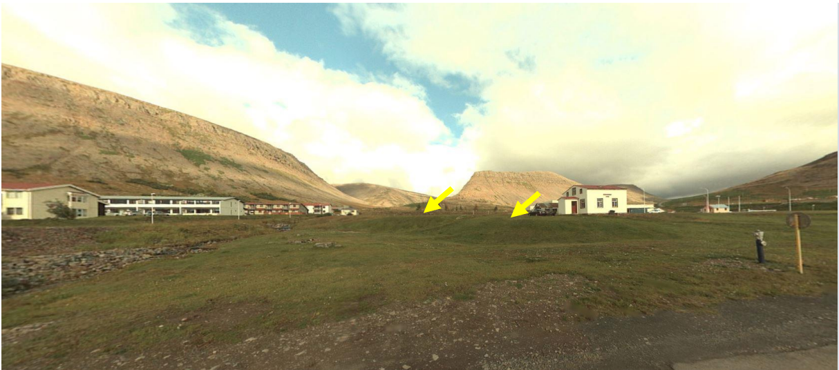
Mynd 10.25 Landmótun við Litladalsá, sem lokið hefur verið við. Hlutverk landmótunar er að taka við krapaflóðum úr ánni. Mynd tekin af ja.is.
