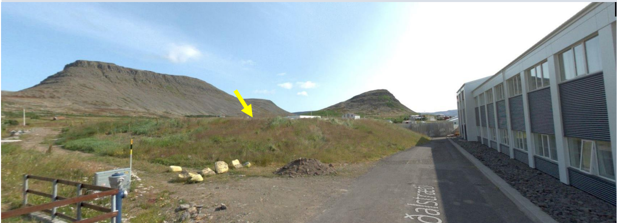
Mynd 10.26 Landmótun við Litladalsá, sem lokið hefur verið við. Hlutverk landmótunar er að taka við krapaflóðum úr ánni. Mynd tekin af ja.is.
