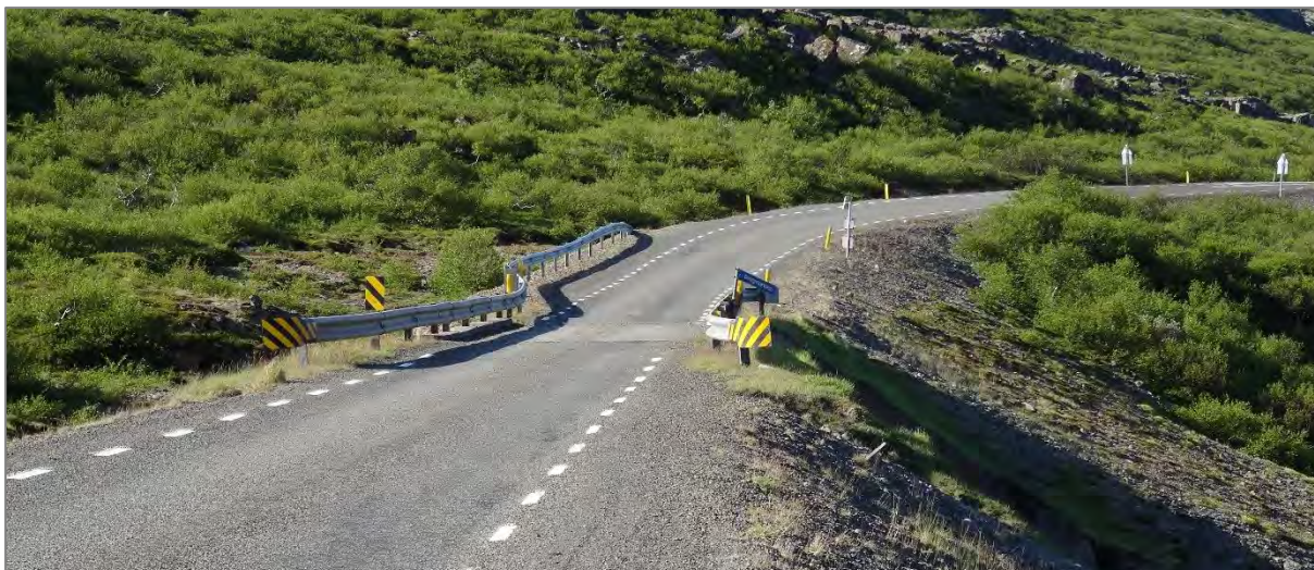
Mynd 8. Einbreið brú á Þingmannaá í Vatnsfirði (mynd: SJ, 2015).
