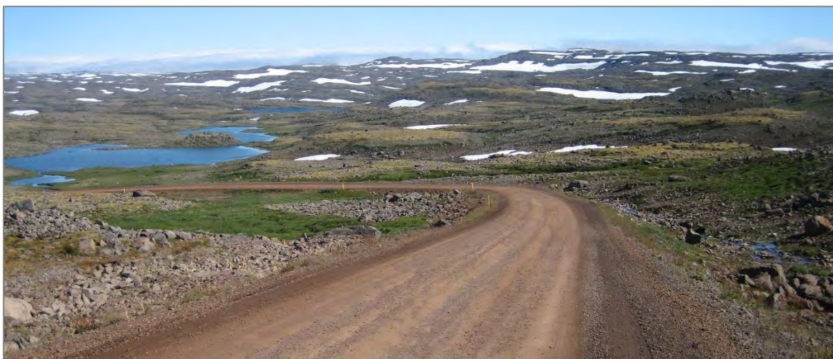
Mynd 21. Kröpp beygja á veginum um Dynjandisheiði (60 m radíus) í grennd við stöð 23000. Vötnin kallast Þverárvötn og vatn úr þeim fellur í Dynjandisá (mynd: HA, 2012).
