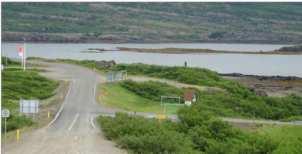
Mynd 11. Vegamót Vestfjarðavegar og Barðastrandarvegar við Flókalund (mynd: SJ, 2016).
