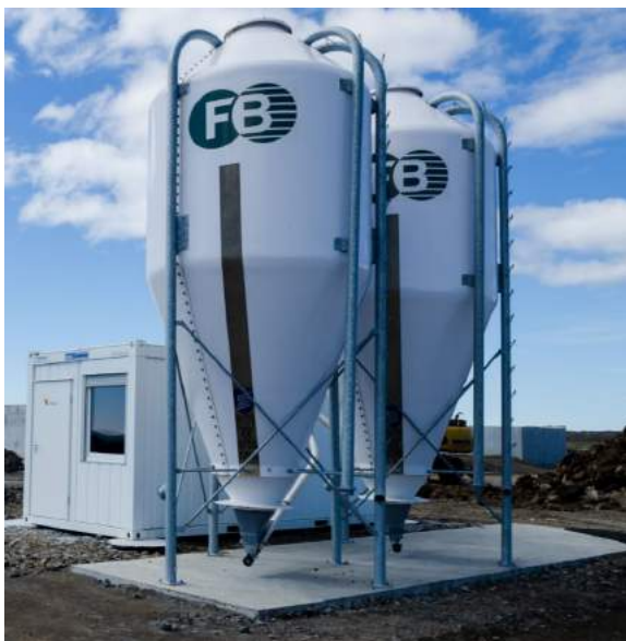
Mynd 12: Fóðursíló við fiskeldisstöð Matorku í Grindavík.
