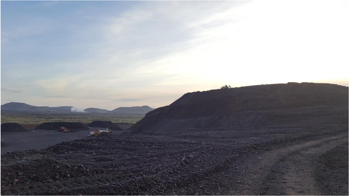
MYND 12 Uppi á Stapafelli má sjá jarðýtu vera að ryðja fram efni.
