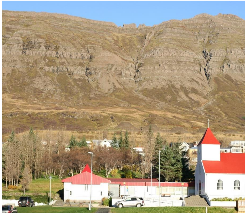
Mynd 7 Horft upp að Drangagilsgarði og keilna ofan hans. Mynd tekin 3. nóvember 2015.
