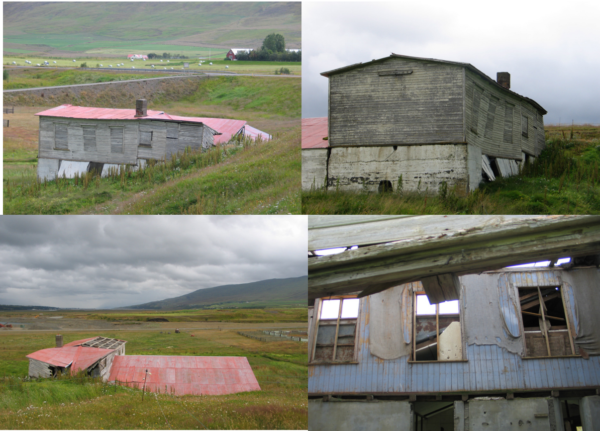
Þinghúsið. Horft til austurs (efri mynd til vinstri), SSA (efri mynd til hægri), norðurs (neðri mynd til vinstri) og neðri myndin til hægri er af austurvegg hússins að innanverðu
