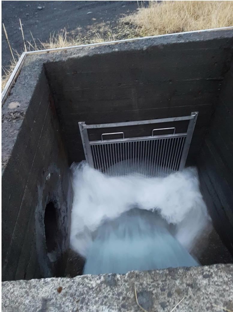
Mynd 3.7 Fiskgildra í frárennsli frá eldisstöð á leið til sjávar.
