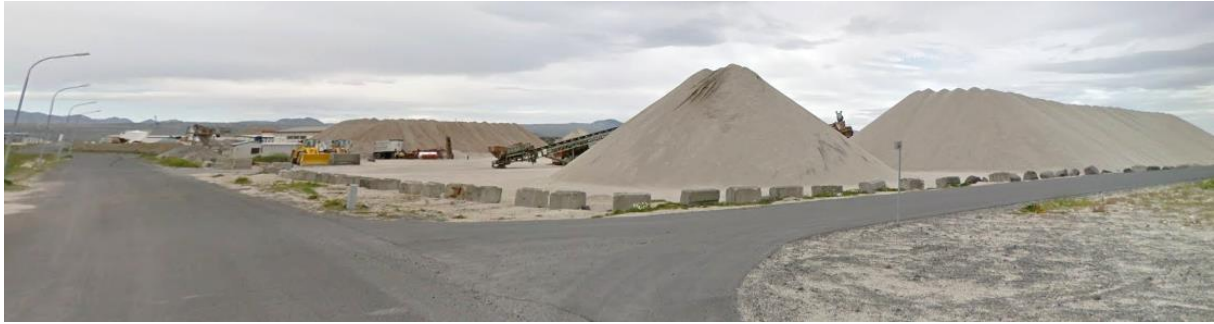
MYND 5.28 Efnislager við Þorlákshafnarhöfn. Engir skjólveggir eða skýli en sýnir ágætlega hvernig efni er safnað saman á lóð. Mynd: Google maps.
