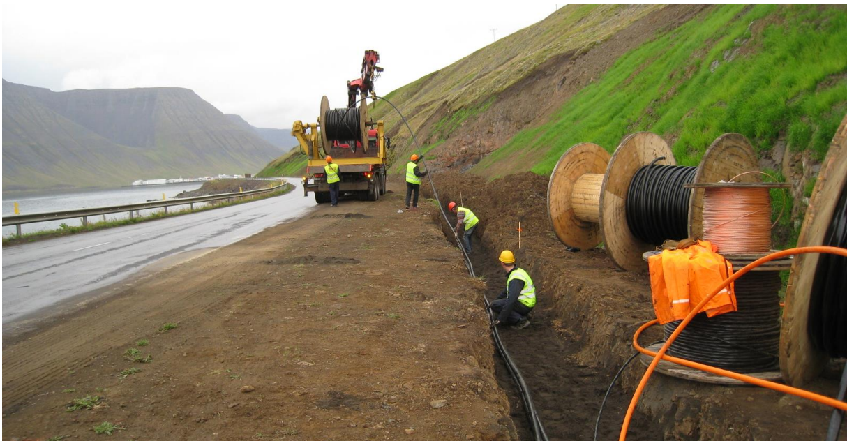
Mynd 4.9 Grafinn skurður með 66 kV streng og kefli.
