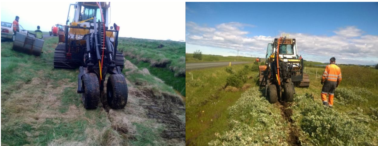
Mynd 4.8 Plægning á 11 kV rafstreng í jarðveg og gras vinstra megin og jarðveg og víðigróður hægra megin. Á myndunum sjást ummerki beint í kjölfar plægingar.
