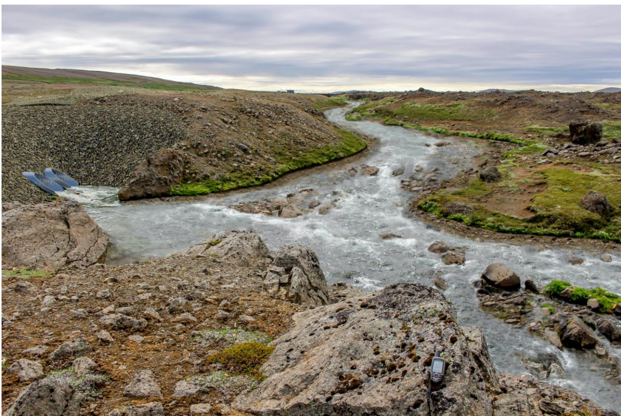
Mynd 5.35 Horft til suðurs frá austurbakka Svartár, rétt neðan við ármót við Grjótá (I). Fylling í Grjótá með ræsi í botninn sést vinstra megin á neðri mynd. Ljósmynd Verkís, 2014.
