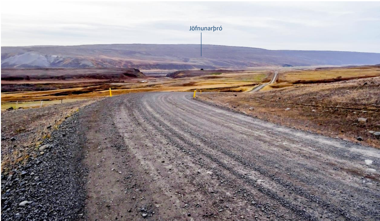
Mynd 5.32 Horft til vesturs frá beygju á Lundarbrekkuvegi í átt á fyrirhugaðri jöfnunarþró, sem er fyrir miðri neðri mynd (G). Ljósmynd Verkís, haust 2016.
