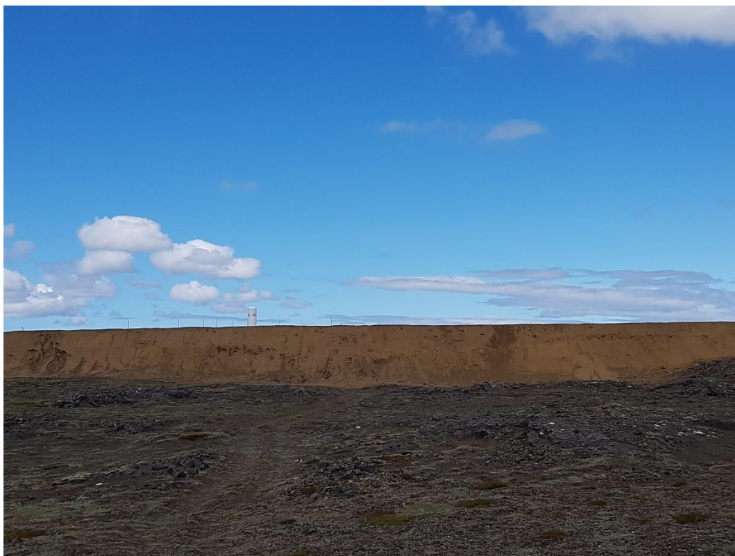
Mynd 35: Af Nesvegi að fiskeldisstöð.
