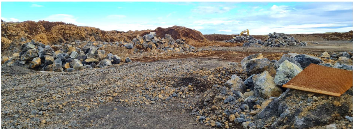
MYND 3.2 Hér sést hraunið þegar búið er að brjóta það niður í viðráðanlega stærð. Í bakgrunn sést í jarðvegslagið sem liggur ofan á hrauninu.
