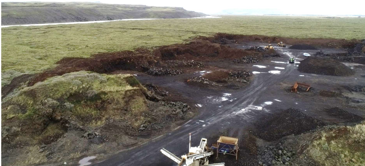
MYND 4.7 Hér sést hvernig yfirborð hraunsins er lækkað.
