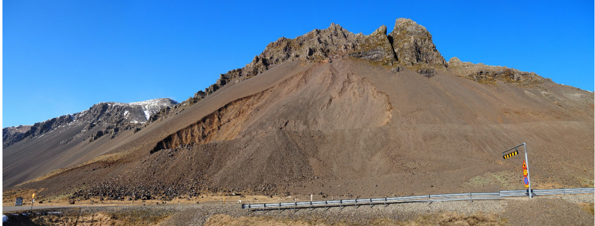
Mynd 9. Námusvæðið í Almannaskarði þann 6. apríl 2022. Talsverðu grjóti og grófara efni hefur verið sturtað eða ýtt fram af gamla veginum á móts við námuna. Æskilegt væri ef hægt væri að nýta það til mölunar eða í rofvarnir og grjóthleðslur.
