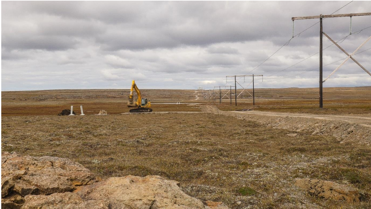
Mynd 6.11. Slóðagerð við Kröflulínu 3. Á myndinni sést núverandi 132 kV loftlína þar sem lögð hefur verið slóð samsíða og undirbúin mastraplön fyrir nýja 220 kV Kröflulínu 3.
