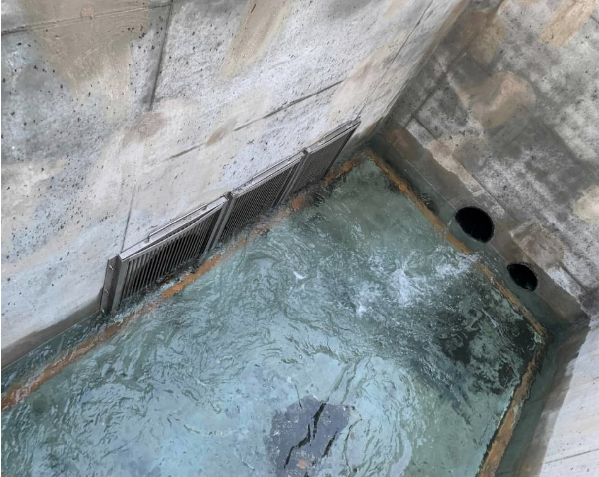
Mynd 3.10 Frárennslispró sem útbúin er með fiskgildru.
