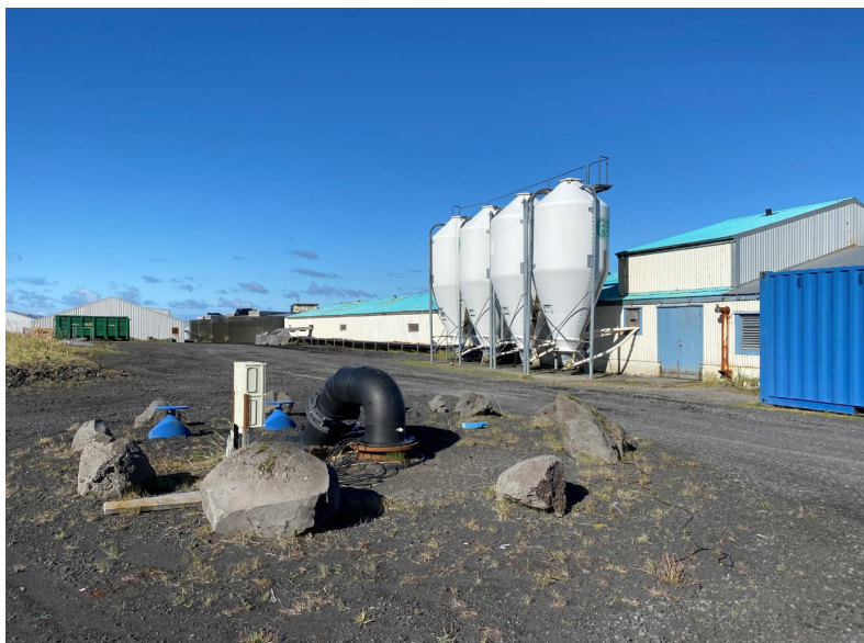
Mynd 3.8 Í forgrunni myndarinnar er ein af mörgum borholum á lóð eldisstöðvarinnar, sem nýtt er til vinnslu grunnvatns. Í náinni framtíð verður byggt hús yfir þessa borholu.
