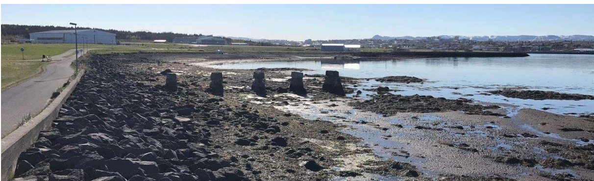
MYND 5.21 Horft í suðaustur yfir framkvæmdasvæði fyrirhugaðrar landfyllingar. Sjá má undirstöður olíubryggjunnar. Núverandi ástand. Ljósmynd: EFLA
