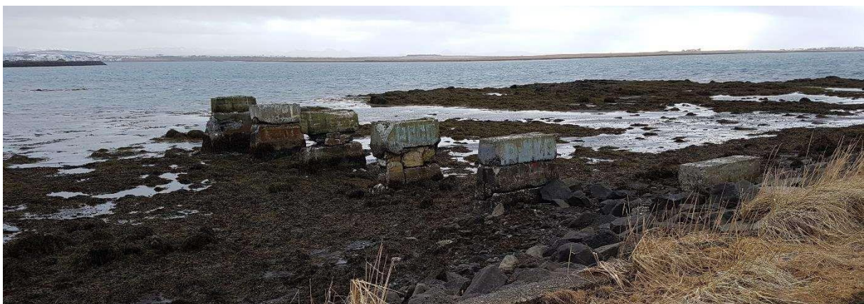
MYND 5.18 Myndin sýnir gamlar undirstöður olúbryggjunnar í fjörunni 2018.
