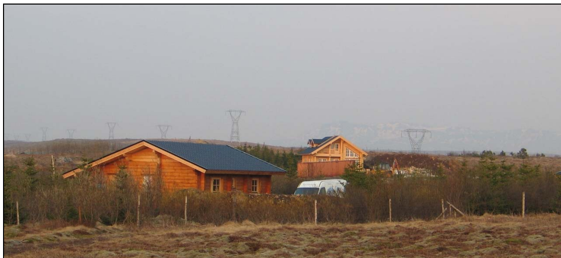
Sumarhúsabyggð við Selvatn skammt austan við Geitháls. Sogslína 3 sést í bakgrunni.
