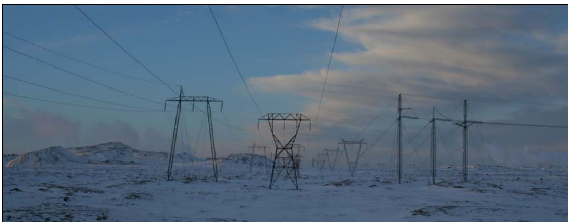
Línufrumskógur? Búrfellslína 2, Sogslína 2 og Búrfellslína 3 á Hellisheiði, séðar í átt að Stóra-Reykjafelli.
